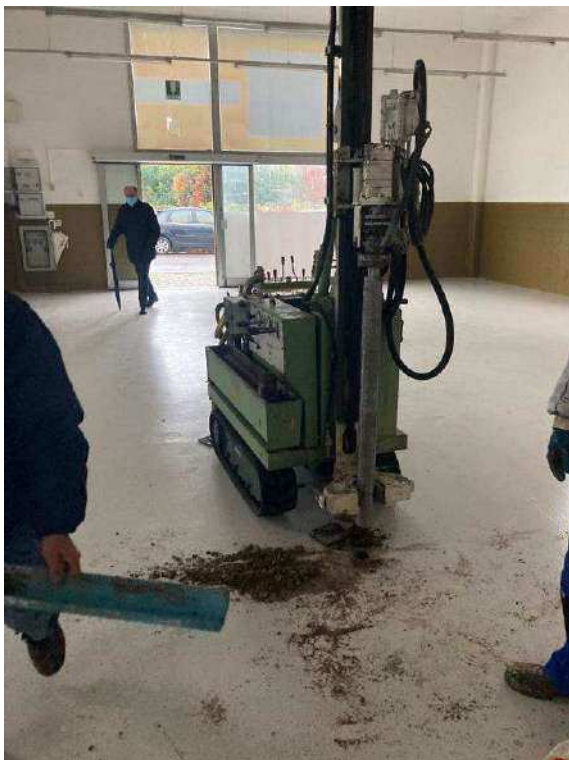
Esecuzione del sondaggio S1
