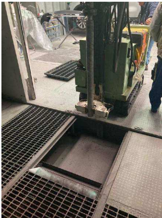
Esecuzione del sondaggio S2
